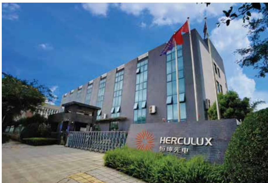
成都双流区自建超20000 m 2 恒坤光电园
